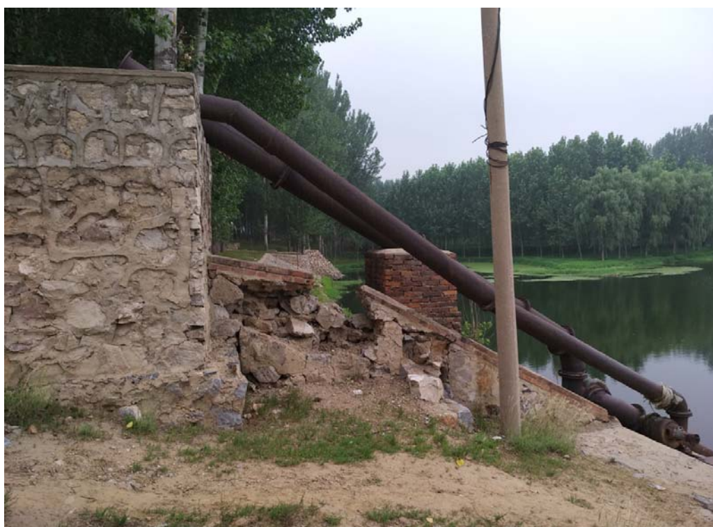
图 16 穿堤建筑物现状见图
