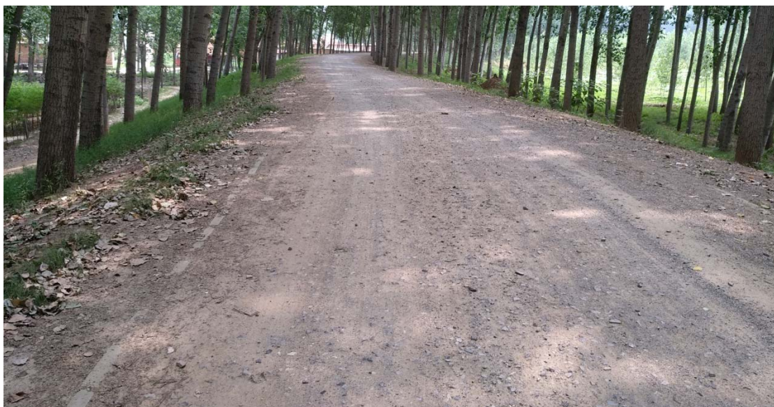
图 11 泥结石路面堤顶现状 1
