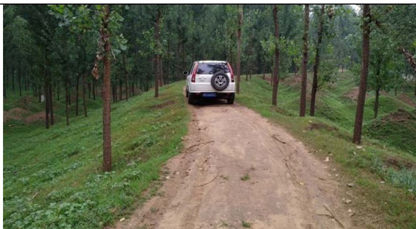
图 30 L20+100~L24+000 段堤坡现状
