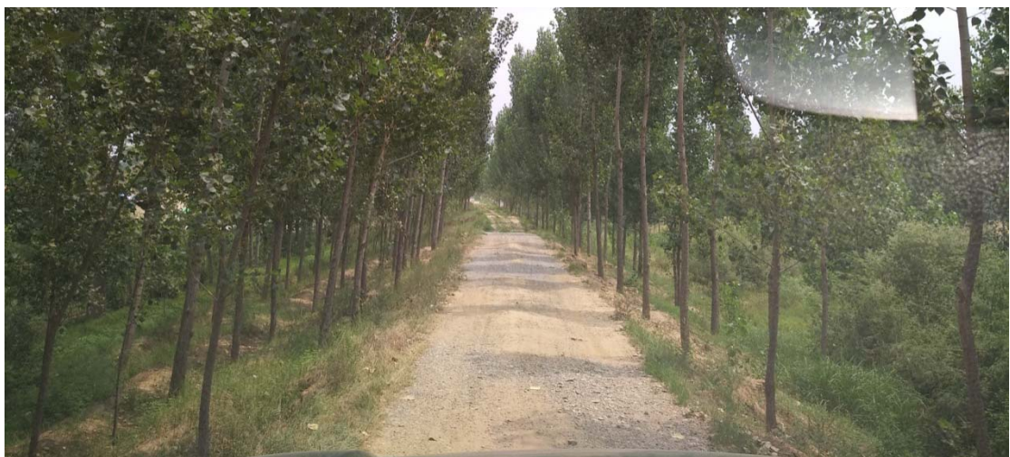
图 7 现状局部路面摊铺碎石
