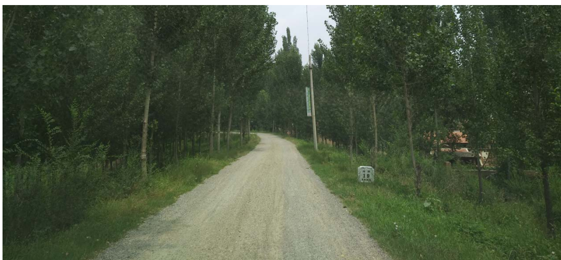
图 12 泥结石路面堤顶现状 2
