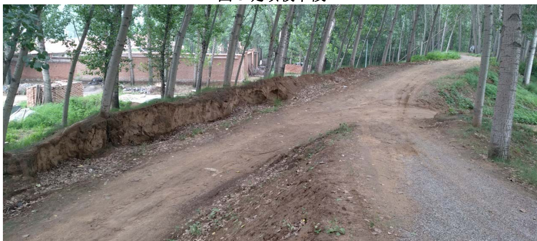
图 9 上堤路挖堤处 1
