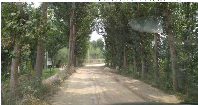
图 29 L2+590~L4+300 复堤段堤顶路两侧乔木林
