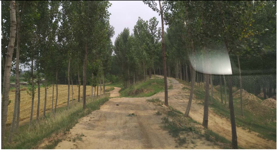
图 5 上堤路挖堤处 1
