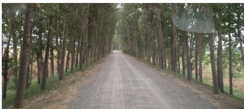
图 28 L0+000~L2+590 复堤段堤顶路两侧乔木林
