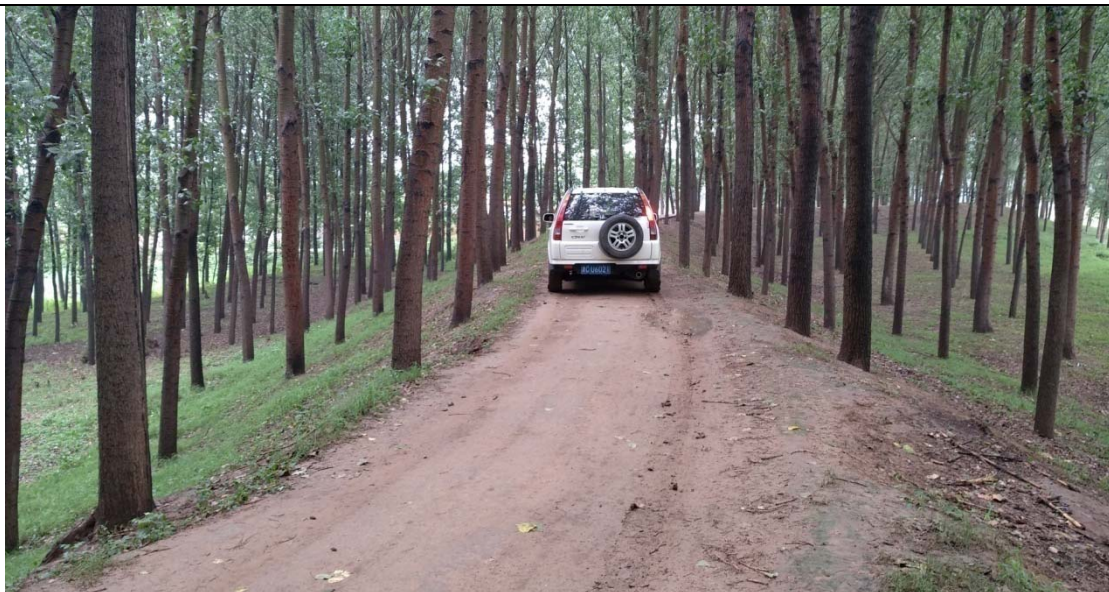
图 15 现状堤顶路面 2
