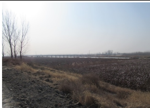
左堤内堤坡植被现状 02
