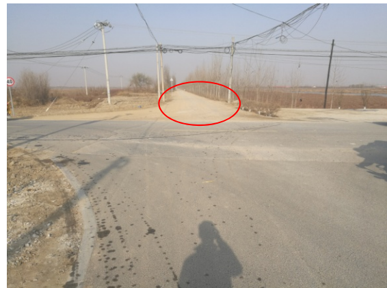
右堤治理工程终点
