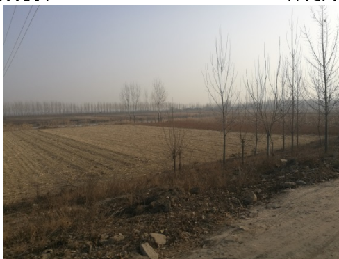
右堤内堤坡植被现状 03
