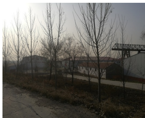
右堤外堤坡植被现状 02
