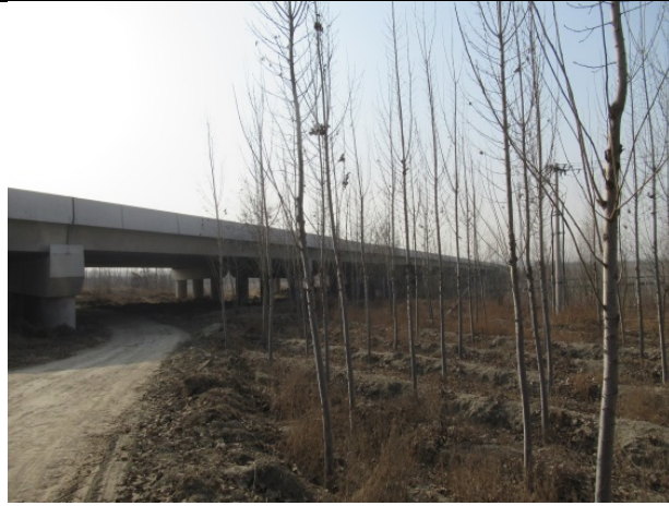
右堤与唐廊高速下穿交叉处堤顶现状
