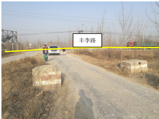
右堤治理工程起点
