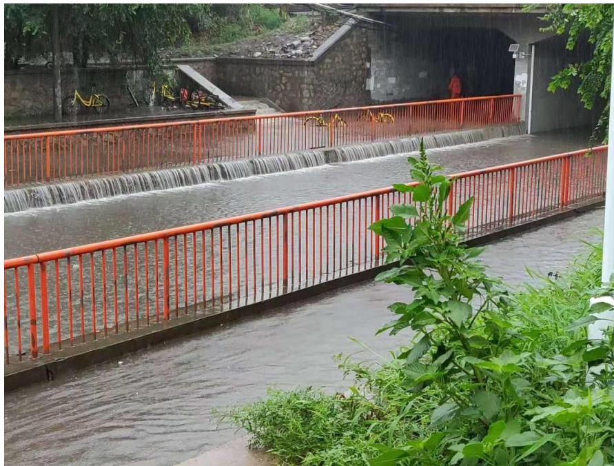
图 1 地道现状积水情况
